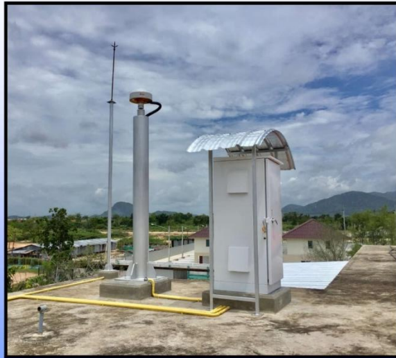
ติดตั้งบนอาคาร
